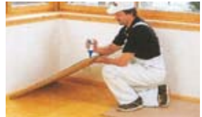
Liaporfitstreifen mit Waaglatten: in den Zwischenraum eingefülltes Liaporfit mit Waaglatte abziehen.
