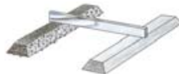
Die parallelen Estrichstreifen mit einer Waaglatte abziehen.
