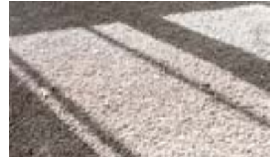
Vor dem weiteren Fußbodenaufbau ist auf eine ausreichende Austrocknung zu achten.
